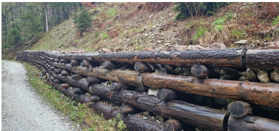
Slika 2: Stranska lesena kašta ob gozdni cesti pod plazljivim pobočjem
