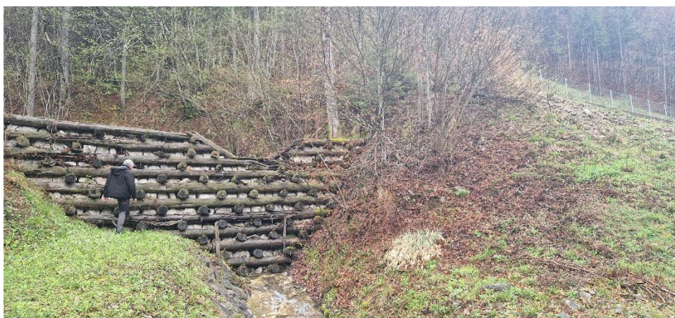
Slika 1: Ogled kranjske stene na hudourniku Dašnica
