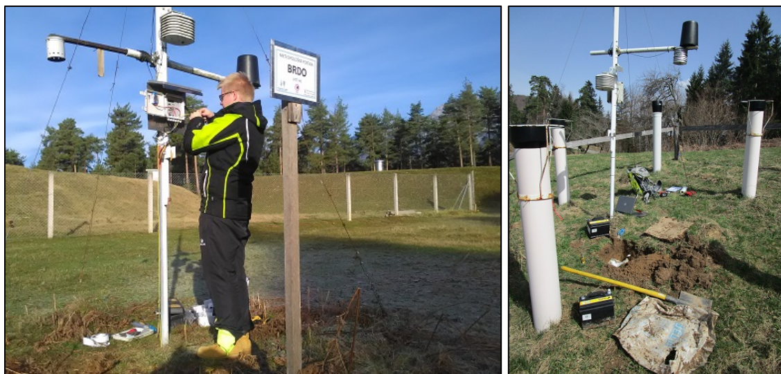
Slika 31: Posodobitev meteorološke postaje Brdo (levo) in obnova napajalnega sistem meteorološke postaje Borovec (desno) (Foto: I. Sinjur).
